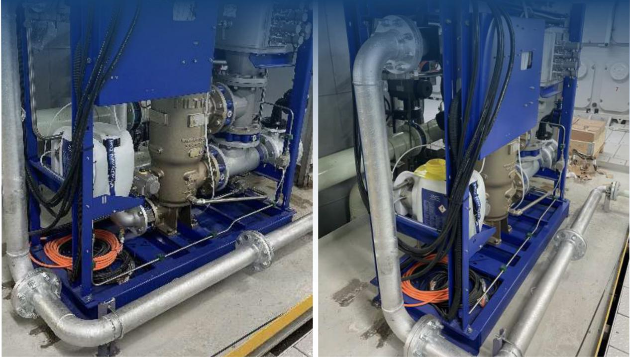
Completa installazione di Fuel Flow meters/quick closing valves (incluso di impianto di aria compressa e cablaggio elettrico)
